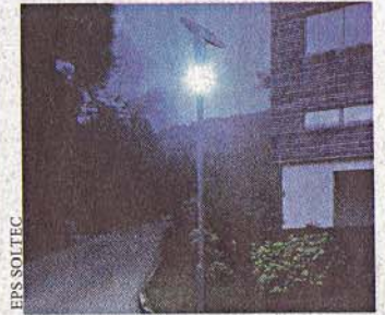
Solarenergie für Straßenlicht
